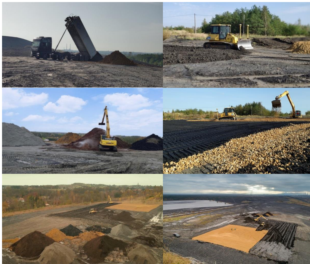
Rys. 16 Prace terenowe nad wykonanie poligonu badawczego
